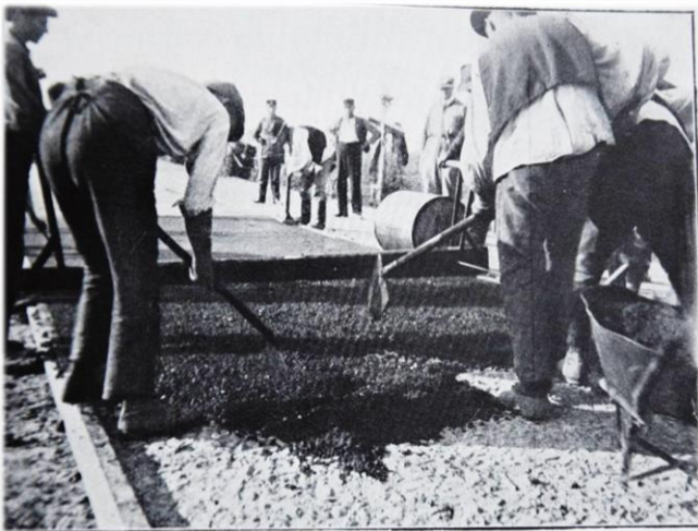
Obr. 62. Rozprostírání těžké vozovky na vyčištěnou mosaiku nosné vozovky
