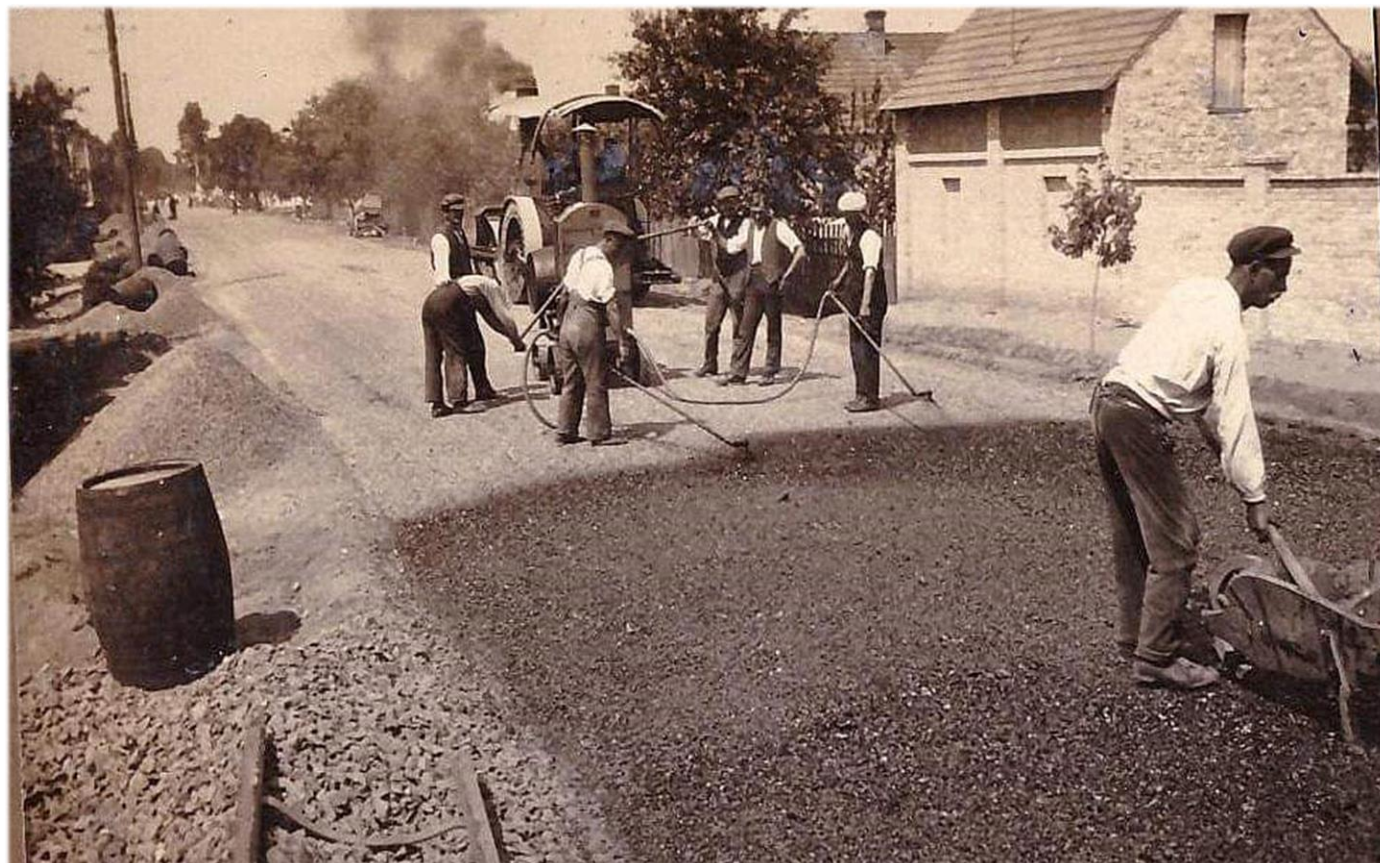
Obr. 64. Válcování těžké vozovky asfalto-dehtové před Buštinou.
